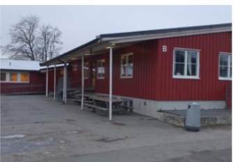
Nidarvoll Skole Bygg B
