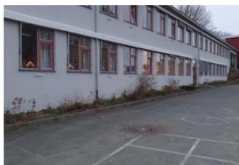
Nidarvoll Skole Bygg C + D
