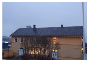
Nidarvoll Skole Bygg E
