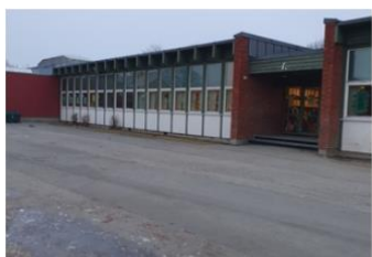
Nidarvoll skole Bygg A
